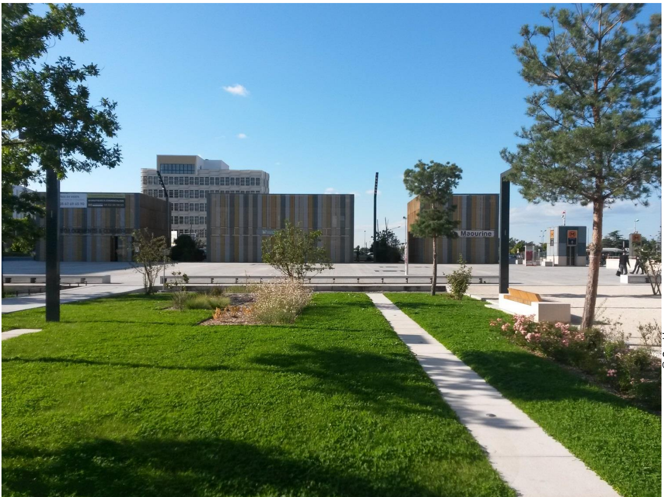
Vue des 3 pavillons, carré de la Maourine, Toulouse
